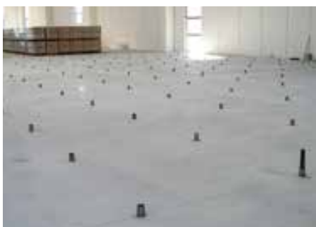
Intervention sur dallage avec injections de polymère expansif et micropieux
