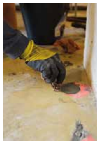
4. Cimentation des micropieux par de spéciaux mortiers expansifs pour ancrage
