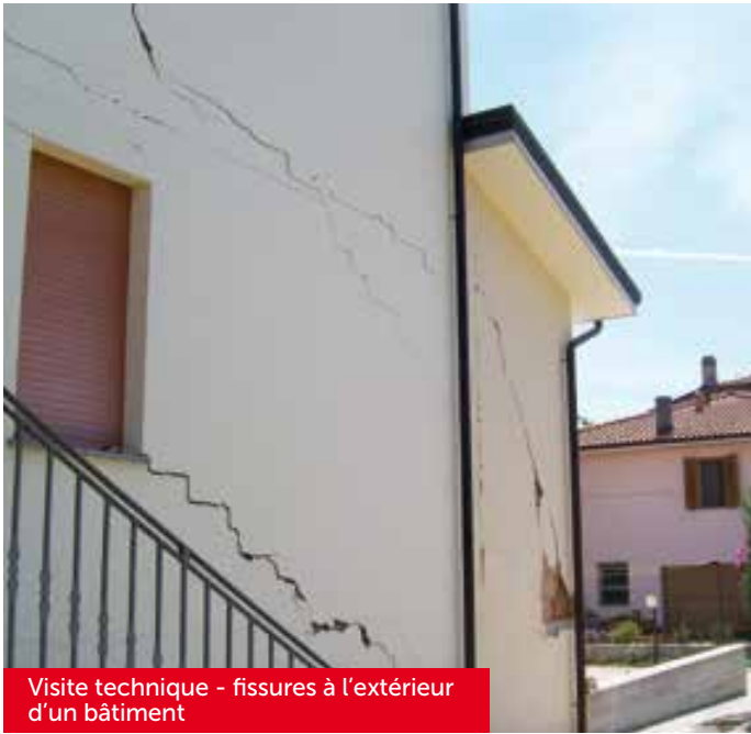
Visite technique - fissures à l'extérieur d'un bâtiment
