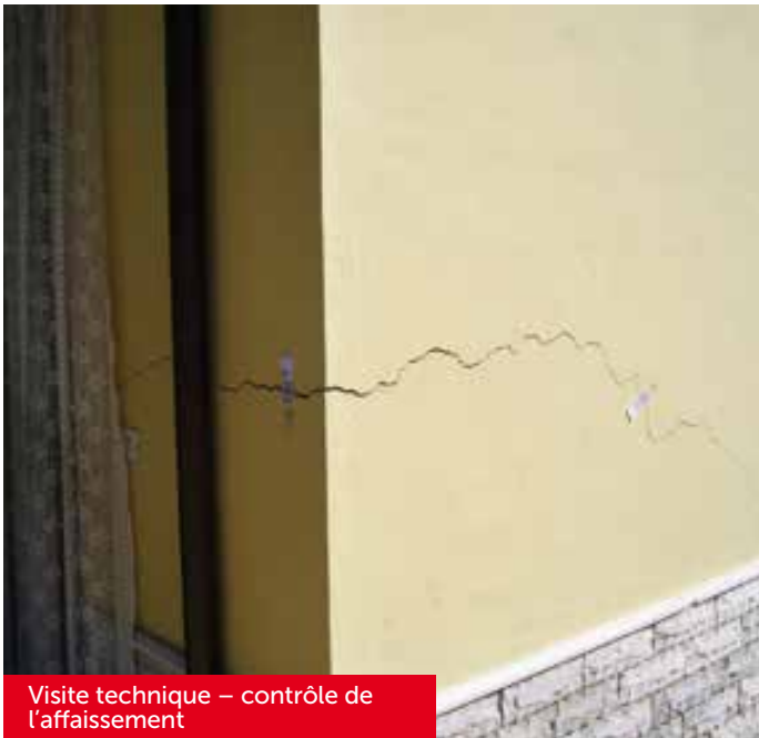
Visite technique - fissures à l'extérieur d'un bâtiment
