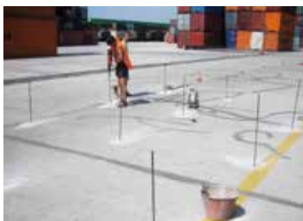
Injections de polymère expansif sur dallage à l'extérieur
