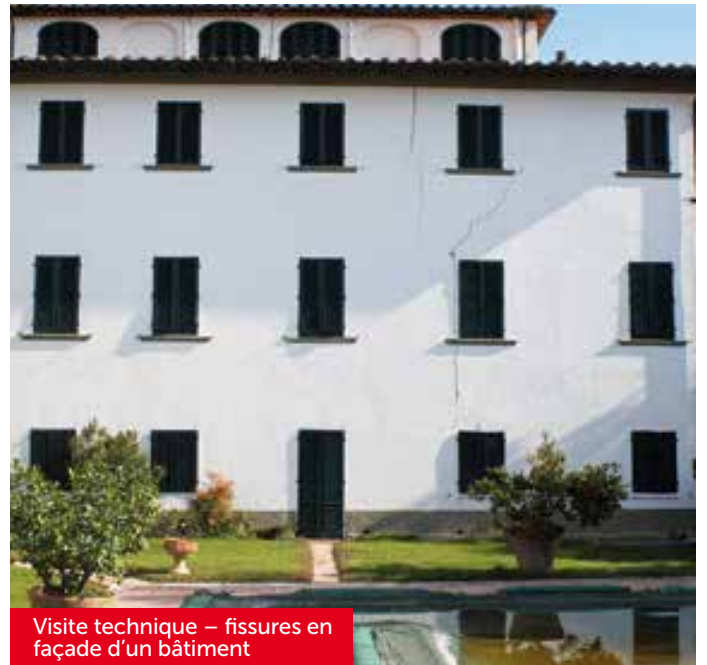
Visite technique - fissures à l'extérieur d'un bâtiment
