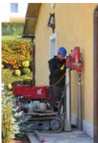
1. Carottage de la fondation existante
