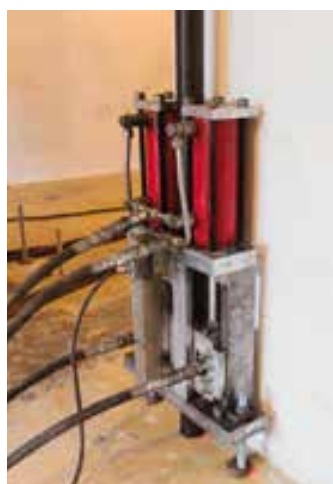
2. Enfocement des MP60 dans le terrain avec ancrage à la fondation à travers des barres d'ancrage en acier
