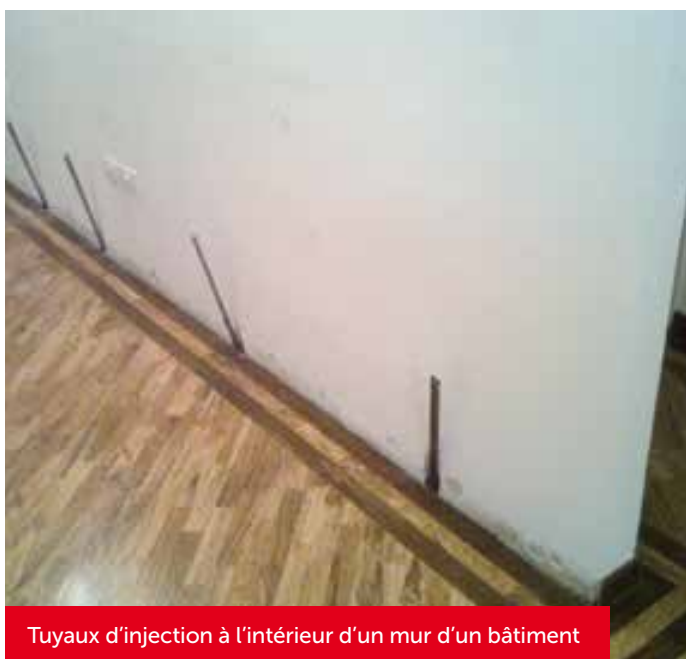
Injection du polymère expansif
