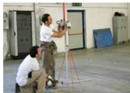
Injections de polymère expansif avec contrôle laser
