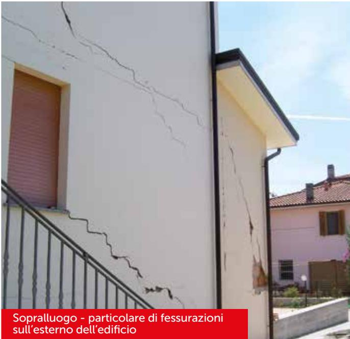
Sopralluogo - particolare di fessurazioni sull'esterno dell'edificio
