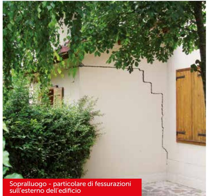
Sopralluogo - particolare di fessurazioni sull'esterno dell'edificio
