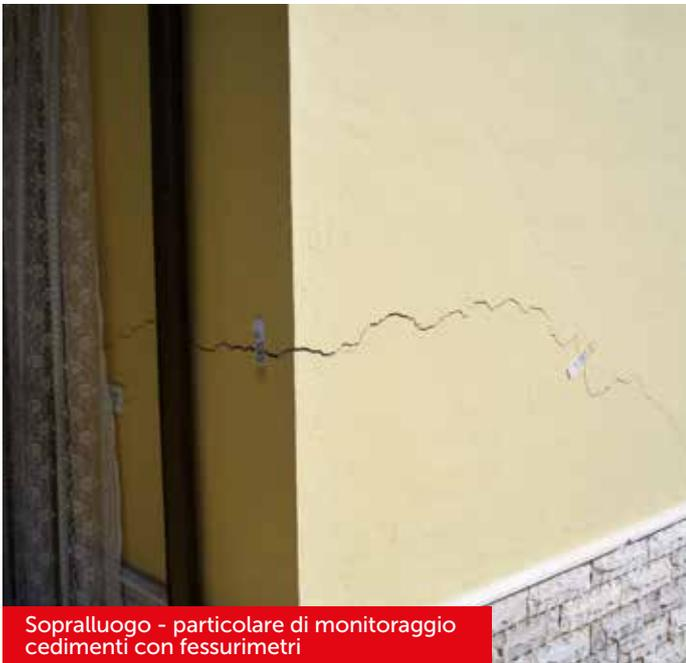
Sopralluogo - particolare di monitoraggio cedimenti con fessurimetri
